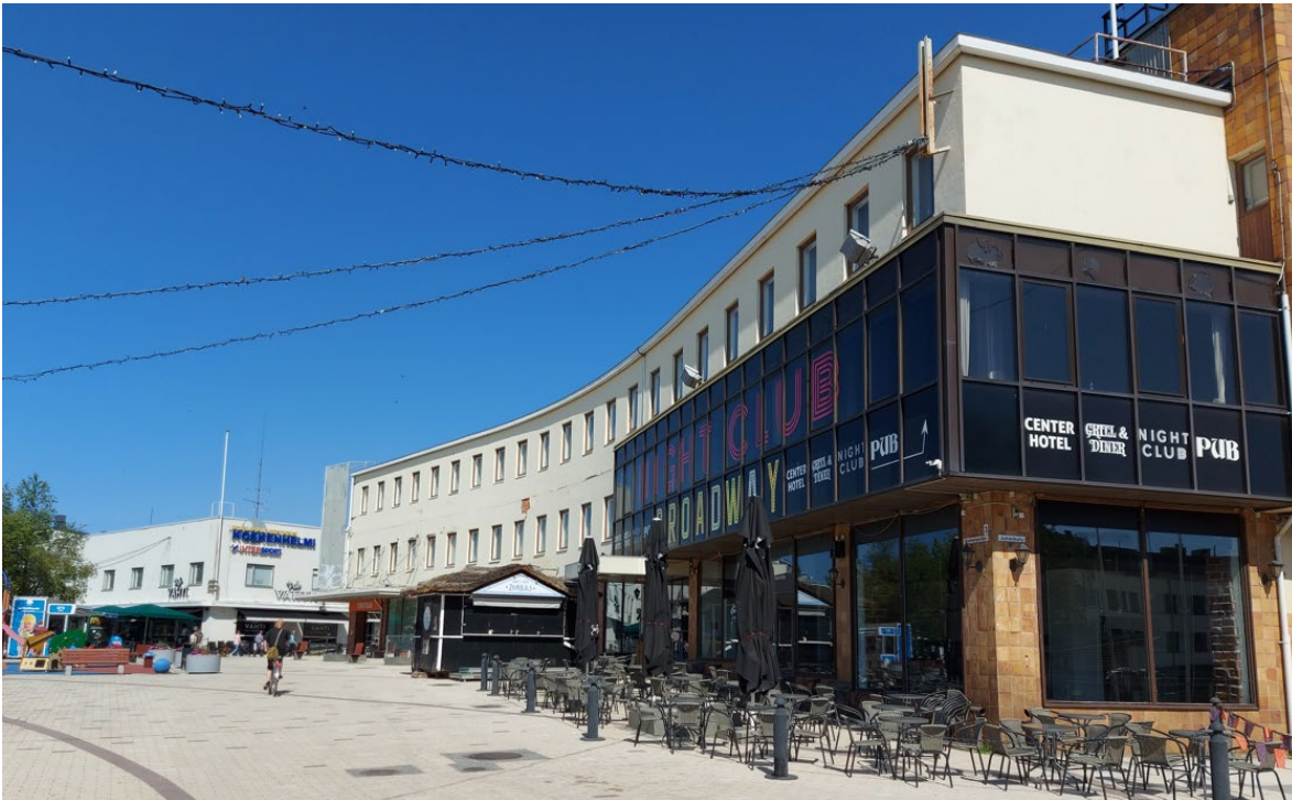
Kuva 4 Imatrankosken funkisrakennukset on luokiteltu maakunnallisesti merkittäväksi kulttuuriympäristöksi.
