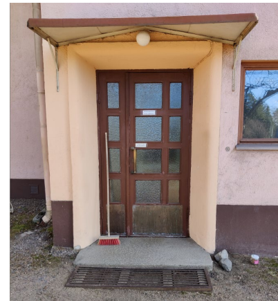
Kuva 45. Porraskäytävän ovi sijaitsee pienessä syvennyksessä. Puinen ovi on alkuperäinen.
