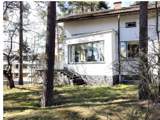
Kuva 33. Katujulkisivun länsipäädyssä oleva erkkeri on hieman isompi kuin itäpäädyn erkkeri.
