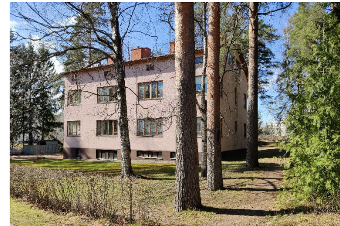
Kuva 35. Kohteen julkisivu Torkkelinkadulle.
