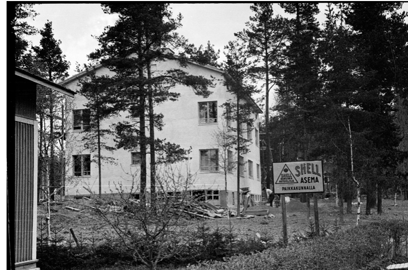
Kuva 36. Rakennustyömaalta otettu kuva, mahdollisesti 1936. Kuvaaja Jalmari Lankinen, Etelä-Karjalan museo.
