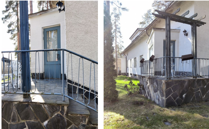
Kuvat 30 ja 31. Itäpäädyn terassille on kulku katujulkisivun erkkerin kautta. Ovi on alkuperäinen, samoin kuin siro metallikaide. Erkkerin rappaus on vaakauritettu muiden seinäpintojen ollessa karkeaa roiskerappausta. Erkkeri ulkonee vinosti muusta julkisivusta.
