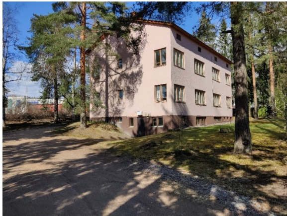
Kuva 42. Kohteen länsipäätä ja Torkkelinkadun puoleinen julkisivu.
