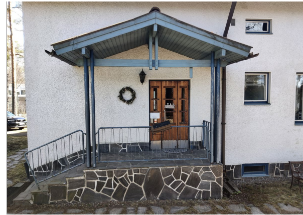
Kuva 27. Sisäänkäynti toiseen kohteen isommista asunnoista. Kuisti on päällystetty liuskekivellä ja kaide on alkuperäinen siro metallikaide.
