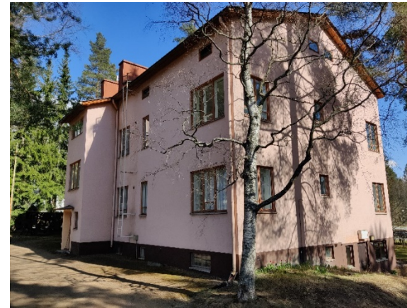
Kuva 44. Kohteen pihajulkisivu ja länsipäätä.
