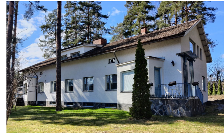
Kuva 20. Kohteen Torkkelinkadun puoleinen julkisivu.
