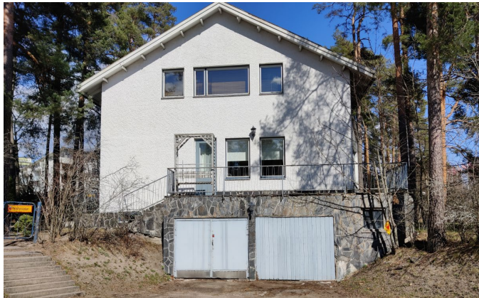
Kuva 29. Länsipäädyn terassin alle on rakennettu alkuperäisistä lupakuvista poiketen autotalli.
