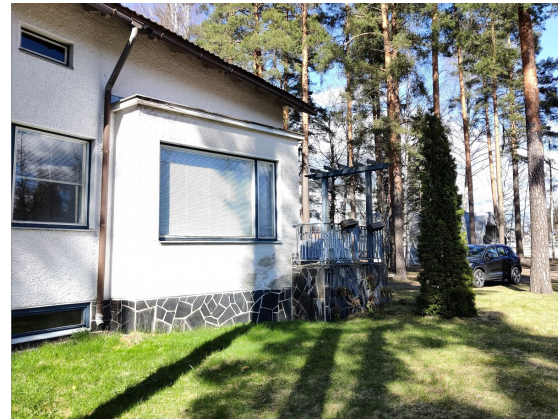
Kuva 32. Katujulkisivun itäpäädyssä oleva erkkeri.
