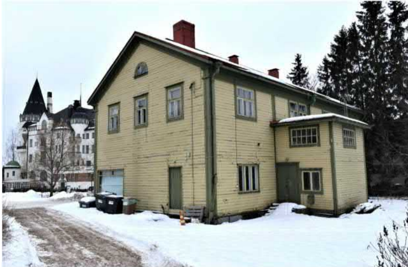
Kuva: Talon takafasadissa porrashuoneen yläpuolella näkyy alkuperäinen pysty jakolista. Talon kaikki ulko-ovet ovat puuvia, joissa kapea makkarapaneelipinta.
