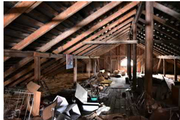
Kuva: Kylmäullakko ja katon puurakenne.
