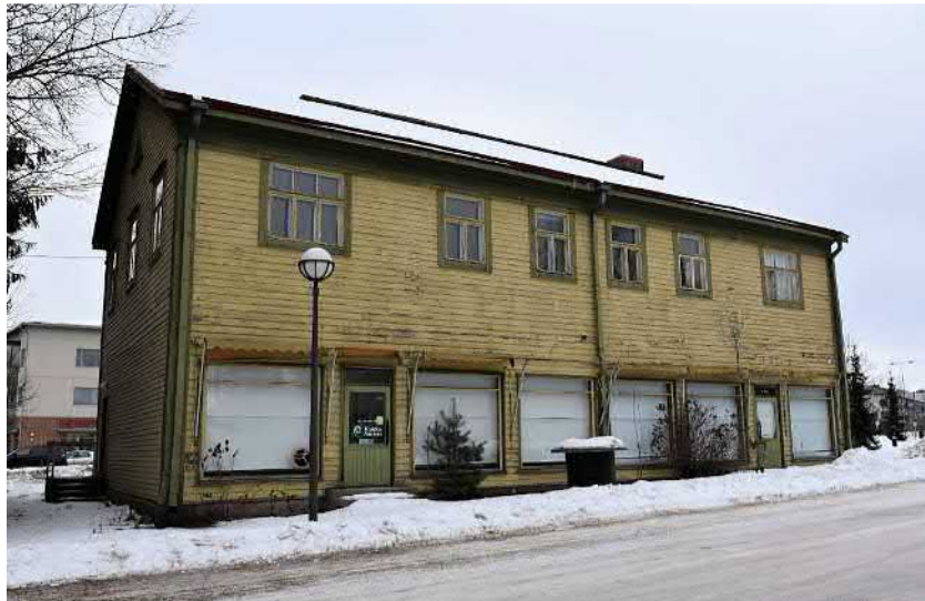
Kuva: Lähteen talo keväällä 2017. Lautavuoraus on alkuperäinen ainakin yläkerran osalta, mutta alakerran osalta laudoitusta on jouduttu uusimaan aukotukseen tulleiden muutosten johdosta. Väriytyy on muuttanut muutamaan kertaan.
