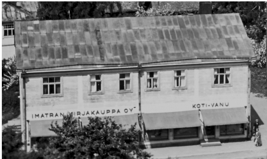
Kuva: Asuin- ja liikeyrakennuksen julkisivu vuonna 1955 muutokorjauksen jälkeen. Yläkerran laudoitukseen on jäänyt jäljet poistetuista pystylistoista. / Osasuurennos, Kuva Ritva Rossi. Veikko Puskan kuva-aineistot.
