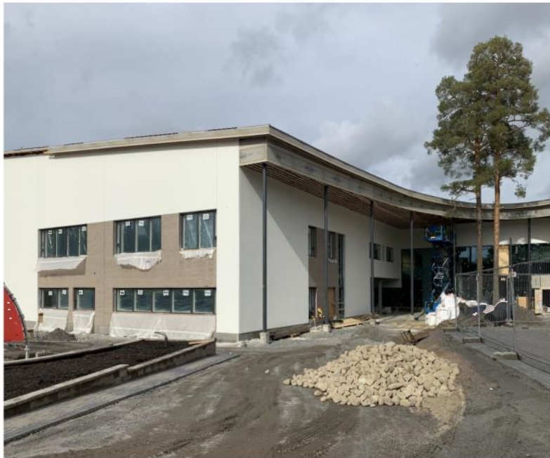
Kosken koulukeskuksen työmaa syksyllä 2020 (Kuva Imatran kaupungin viestintä)
