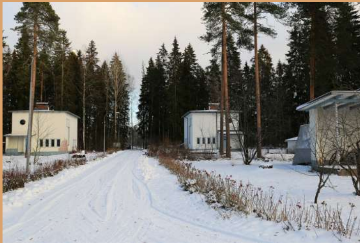
Kaksikerroksiset perheasunnot puistoakselin päädysä.
