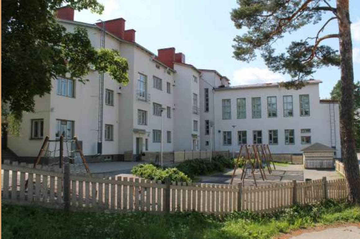
Tainionkosken koulurakennus on säilynyt pääosin ulkoperäisessä ulkoasuussaan. Julkisivussa huomattavin muutos on vuonna 1948 toteutettu rakennuksen länsiosan yhden kerroksen korotus.
