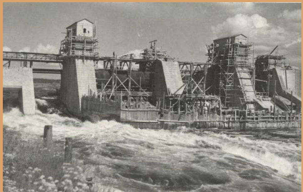
Imatran voimalaitoksen ja padon rakennustyöt vuonna 1928. Kuva: Työvään arkisto.
