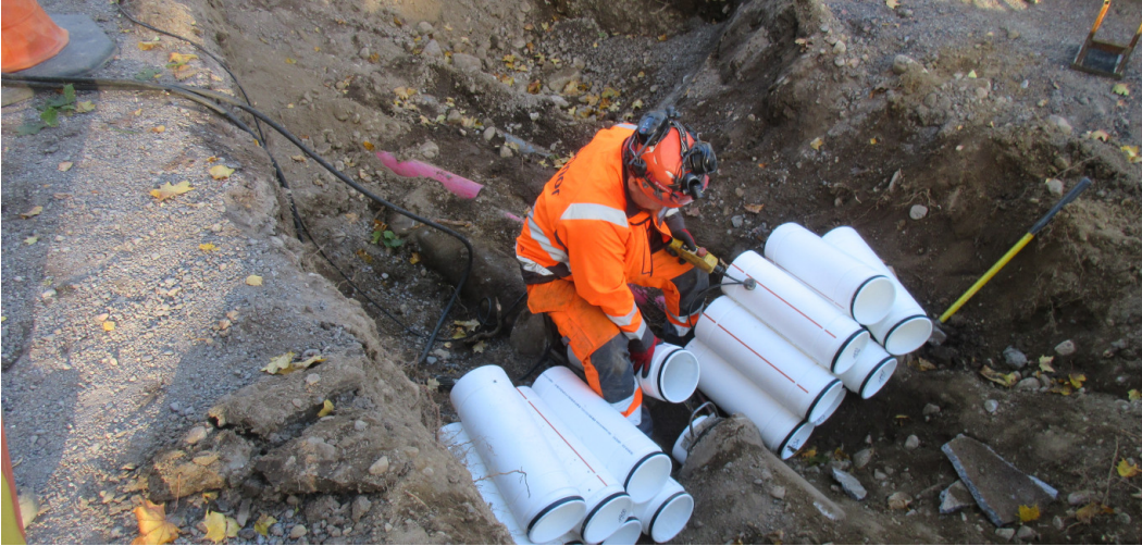
Sujutusta puolen metrin mittaisilla putkilla
