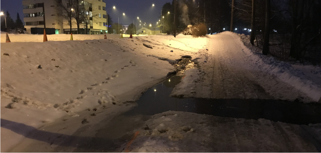
Putkirikko Imatrankoskella, Viipurintien varressa
