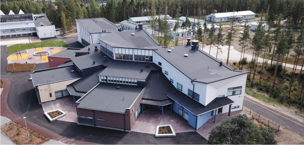
Vuoksenniskan koulukeskuksen uudisrakennus
