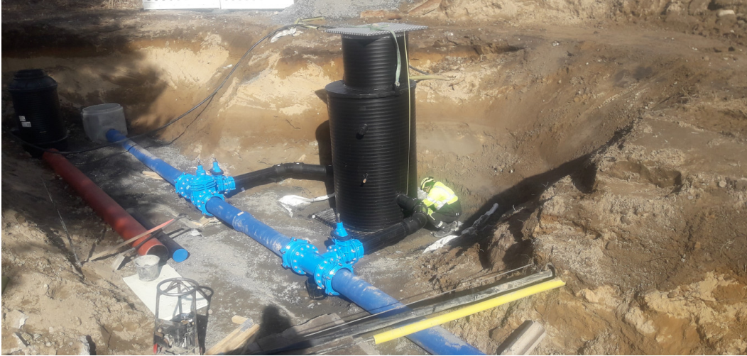
Vesiputkea Myllypuron linjan työmaalta.
