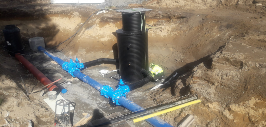
Vesiputkea Myllypuron linjan työmaalta.
