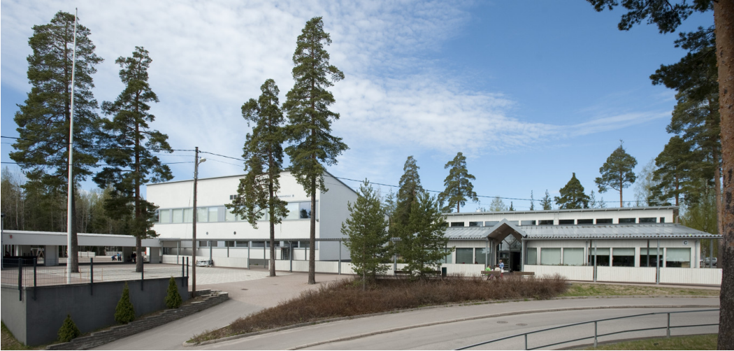
Vuoksenniskan koulukeskuksen vanha puoli.
