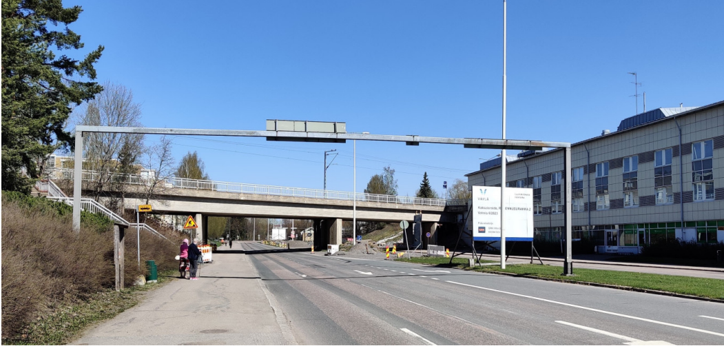
Tainionkoskientien ylittävä rautatiesilta etelästä katsottuna
