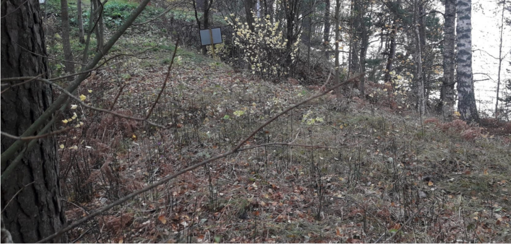
Putkirikon vuotokohta Immolassa
