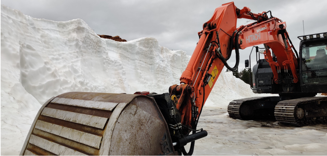
Lumivarasto ja kaivuri Ukkonniemi areenan takana
