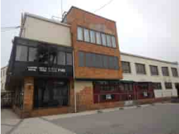
Yleiskuva julkisivusta. Katutason aukotuksia ja julkisivuja on ajansaatossa osin muutettu.
