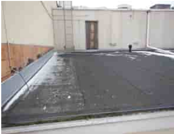
Jukankadun puoleisen siipiosan ja IV-konehuoneen vesikate on kohtalaisen hyvässä kunnossa.
