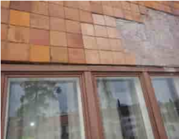
Julkisivun laatoitusta on paikoin uusittu uusilla laatoilla ja osin vauriokohdat on jätetty rappauspinnalle.
