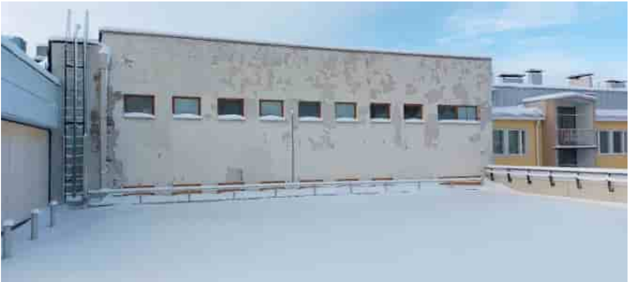
Kuva 78. Entisen konttori ja keskusvaraston julkisivua pihakannella.
