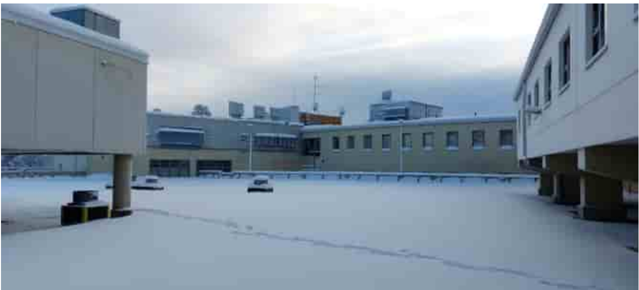
Kuva 76. Julkisivu pihakannella pohjoiseen.
