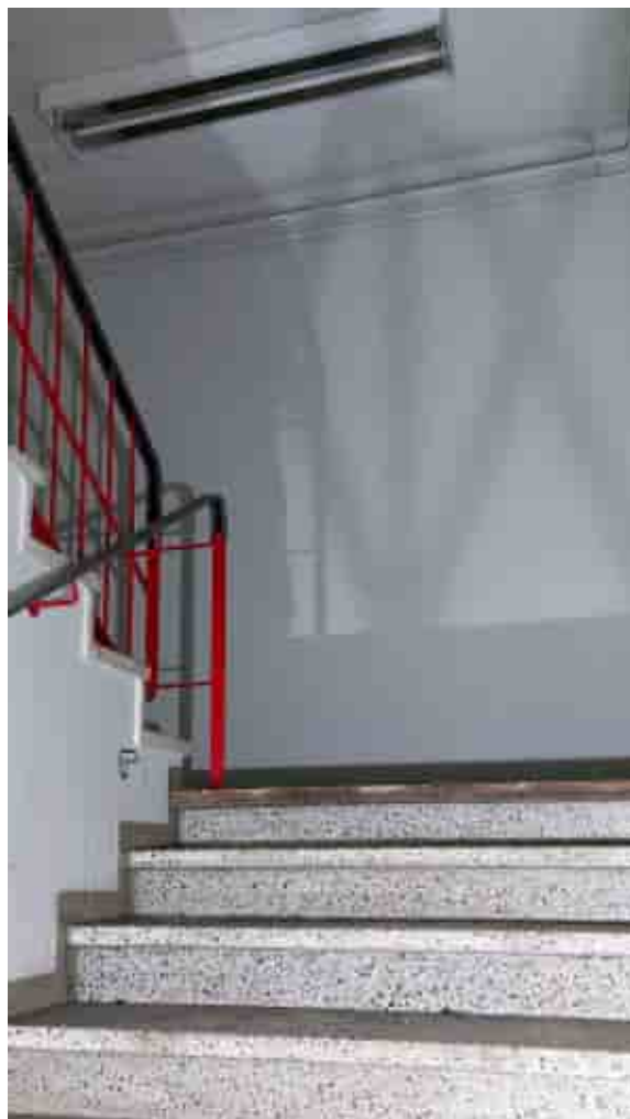
Kuva 90. Matinkadun laajennusosan porrashuone, joka johtaa kellarista ylimpään kerrokseen.
