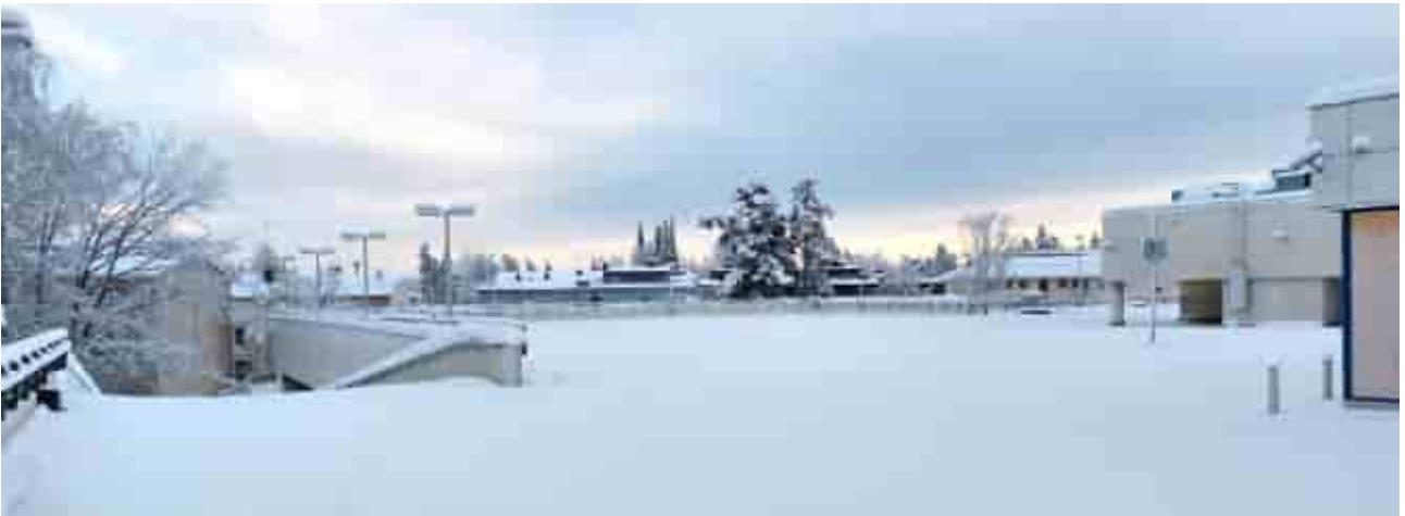
Kuva 67. Autokansi ja ajosilta tontin pohjoislaidalla.
