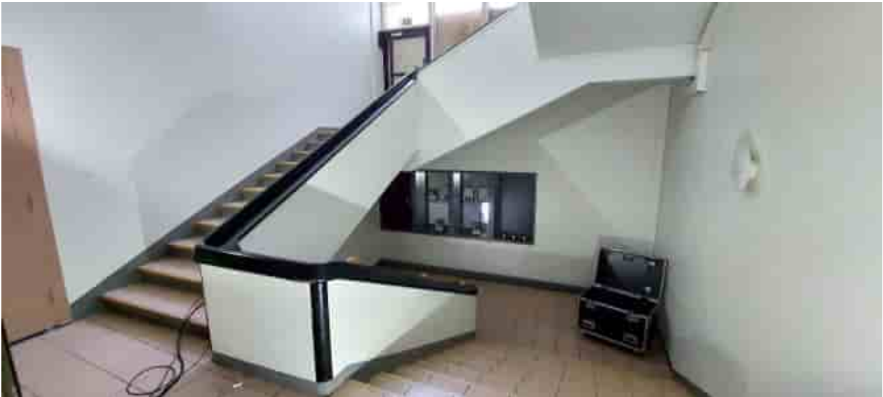
Kuva 93. Hotellin porrashuoneen 2.kerros. Huomion keskipisteenä on 1940-luvun alkuperäinen käsijohde.
