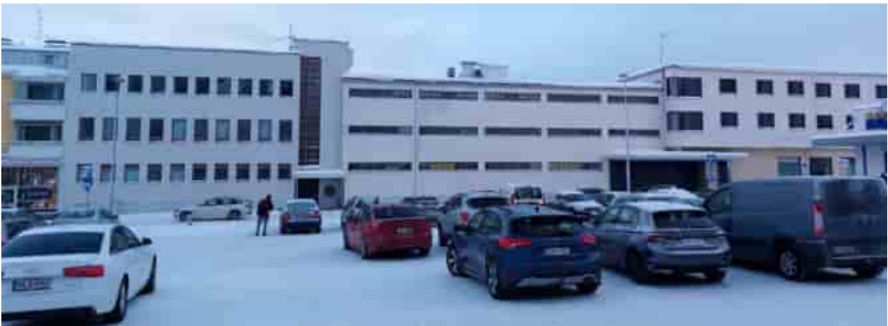
Kuva 73. Julkisivu entisestä konttori ja keskusvarastosta länteen.
