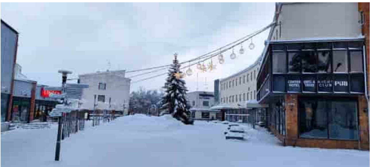
Kuva 59. Yleisnäkymä rakennuksen pääjulkisivulle ja Koskenpartaan aukiolle.
