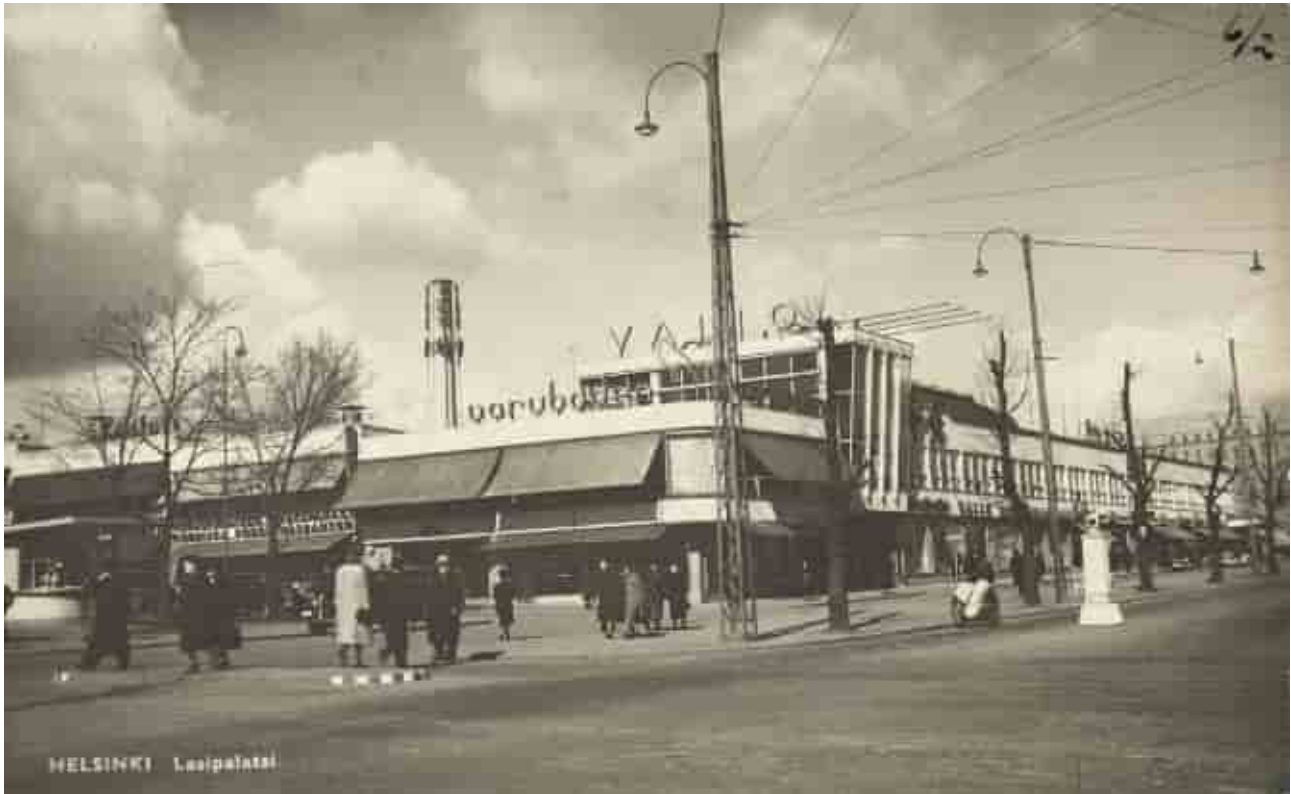
Kuva 32. Lasipalatsi Helsinki. KK:n rakennusosaston suunnittelua, uutuuksena Valion baari, tyyppiratkaisu, joka oli suosittu. Kuvausaika-arvio 1930–1949. Museovirasto. finna.fi (1.3.2024).
