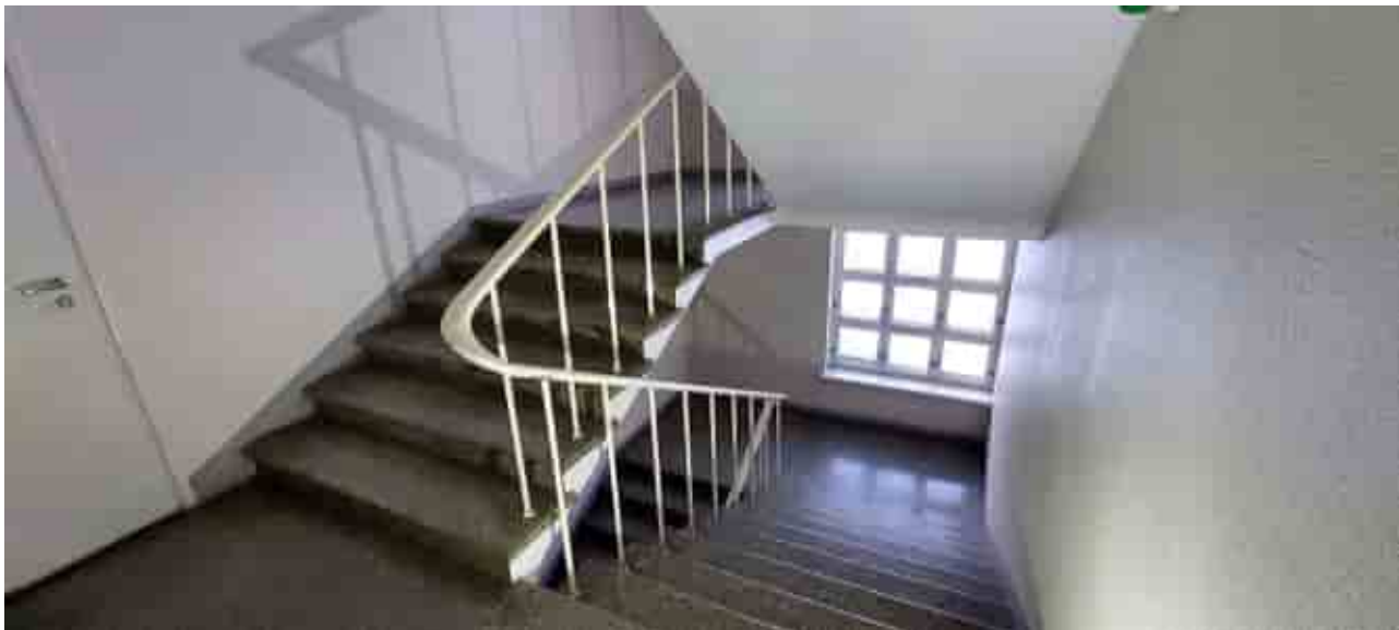
Kuva 107. Konttori- ja keskusvaraston alkuperäinen porrashuone ensimmäisessä kerroksessa.
