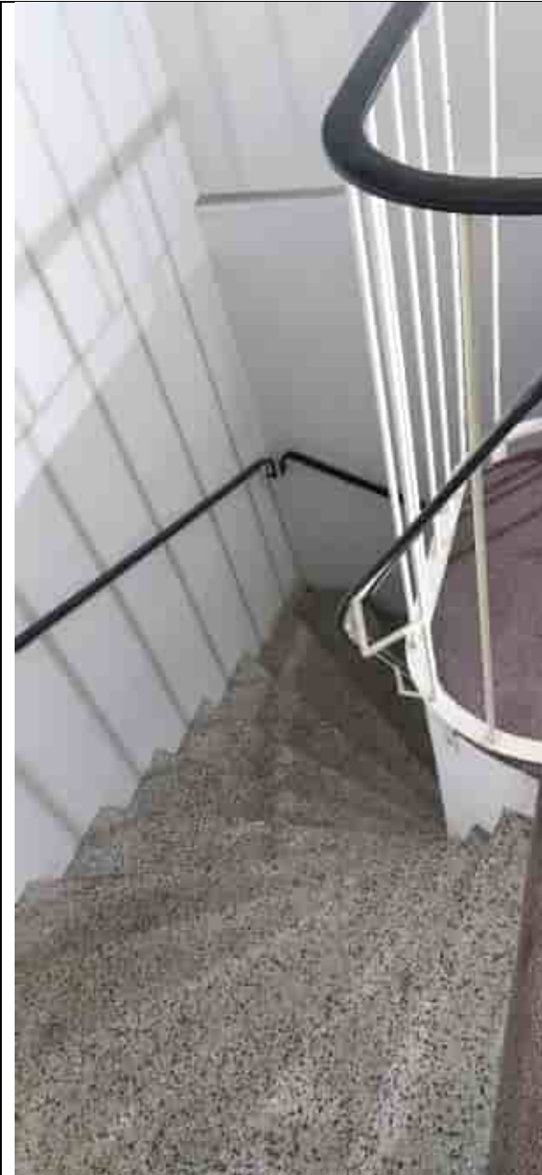
Kuva 91. Matinkadun hotelliosan laajennusosan porrashuone 2. kerroksesta 3. kerrokseen.
