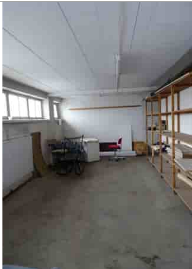
Kuva 109. 2. kerroksen varastotilaa. Varastotiloissa on matalat nauhaikkunat. Kuvaaja: Marjo Tauriainen 20.3.2024
