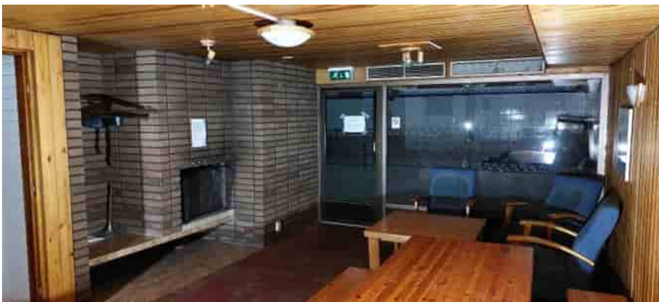
Kuva 86. Kellarin allasosaston takkahuone, joka muutettiin vuonna 1973.
