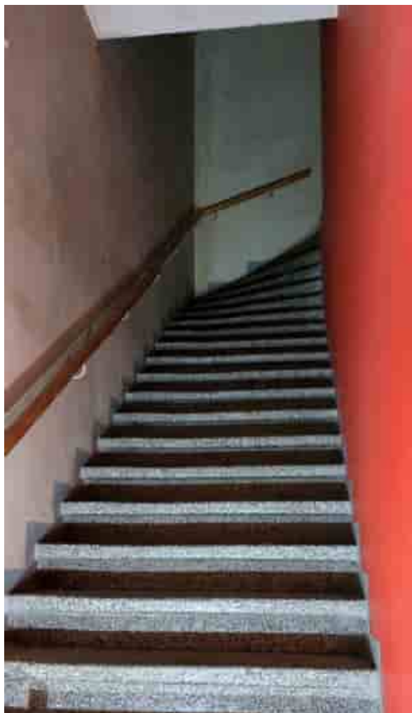
Kuva 89. Jukankadun ja sisäpihan puoleiset kellarin alkuperäiset portaat rakennuksen päädyssä.
