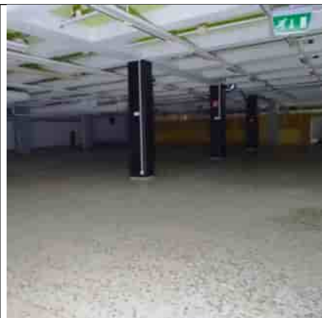
Kuva 113. Ensimmäisen kerroksen myymälätilaa. Kuvaaja: Marjo Tauriainen 20.3.2024
