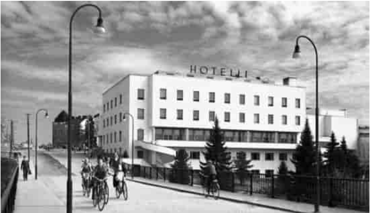
Kuva 31. Sortavalan seurahuone 1930-luvulta. Lähde: agricolaverkko.fi/funkis-arkkitehtuuri-karjalassa/
