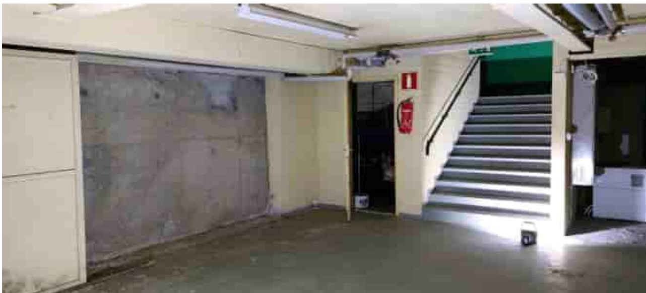
Kuva 88. Kellarin porrashuone konttori- ja keskusvarastorakennuksen ja myymälälaajennusosan rajalla. Konttori- ja keskusvaraston kellarit on muurattu umpeen ja tehty hiekkatäytöt.
