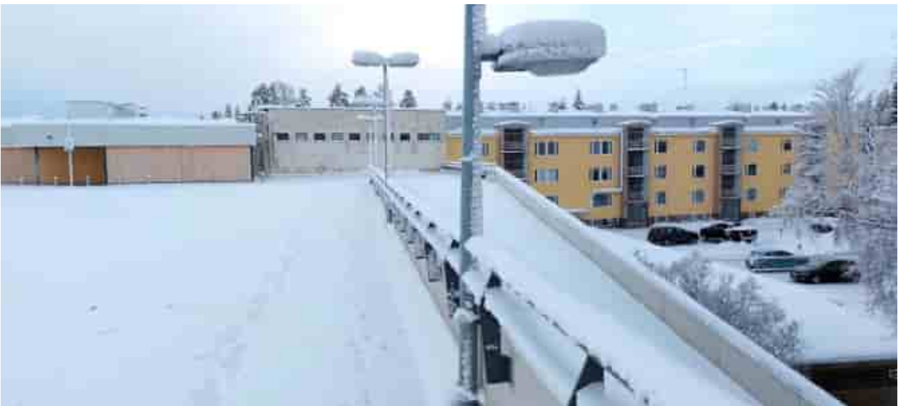
Kuva 66. Autokansi ja ajosilta tontin pohjoislaidalla.
