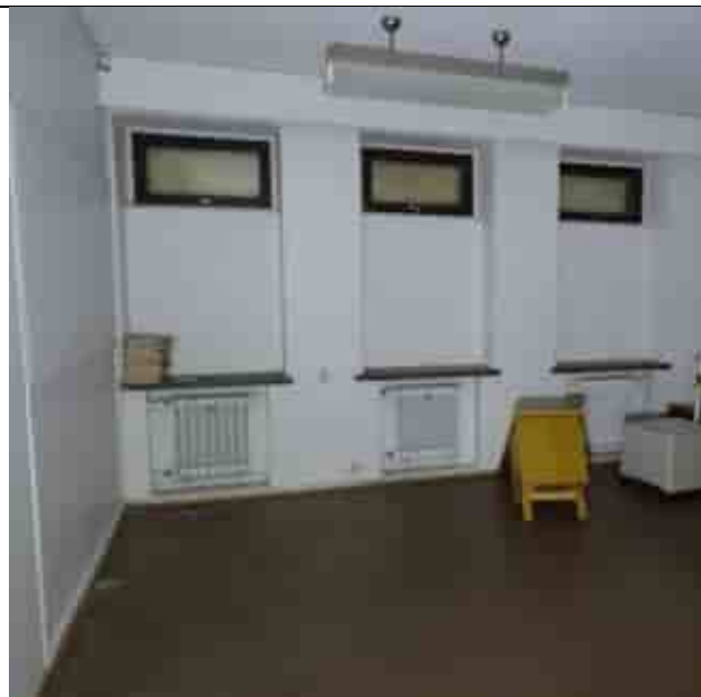
Kuva 115. 2. kerroksen toimistotila. Sisäpihan puolella on tehty ikkunamuutoksia. Kuvaaja: Marjo Tauriainen 20.3.2024
